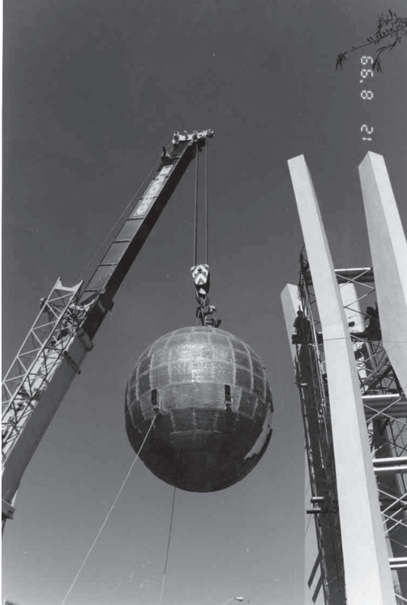
Momento de elevación de la esfera con una grua de 80 ton de fuerza.
